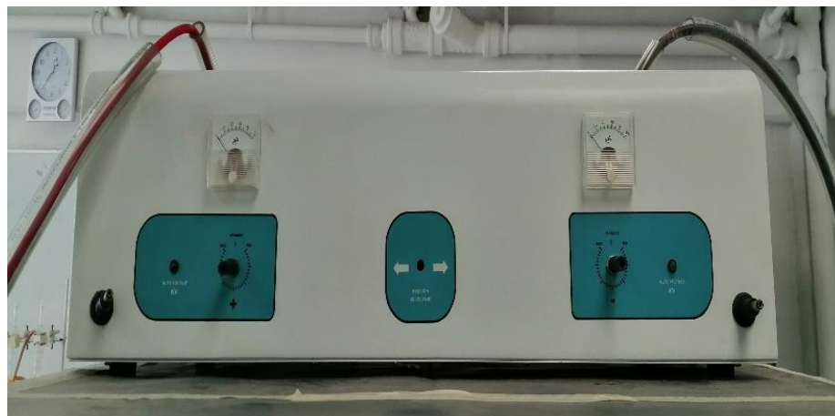
Figura 12. Panel de control para voltajes.
