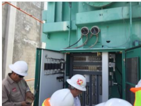
Figura 5.22 Instalación del primer sensor de GIC's subestación Querétaro [21]
