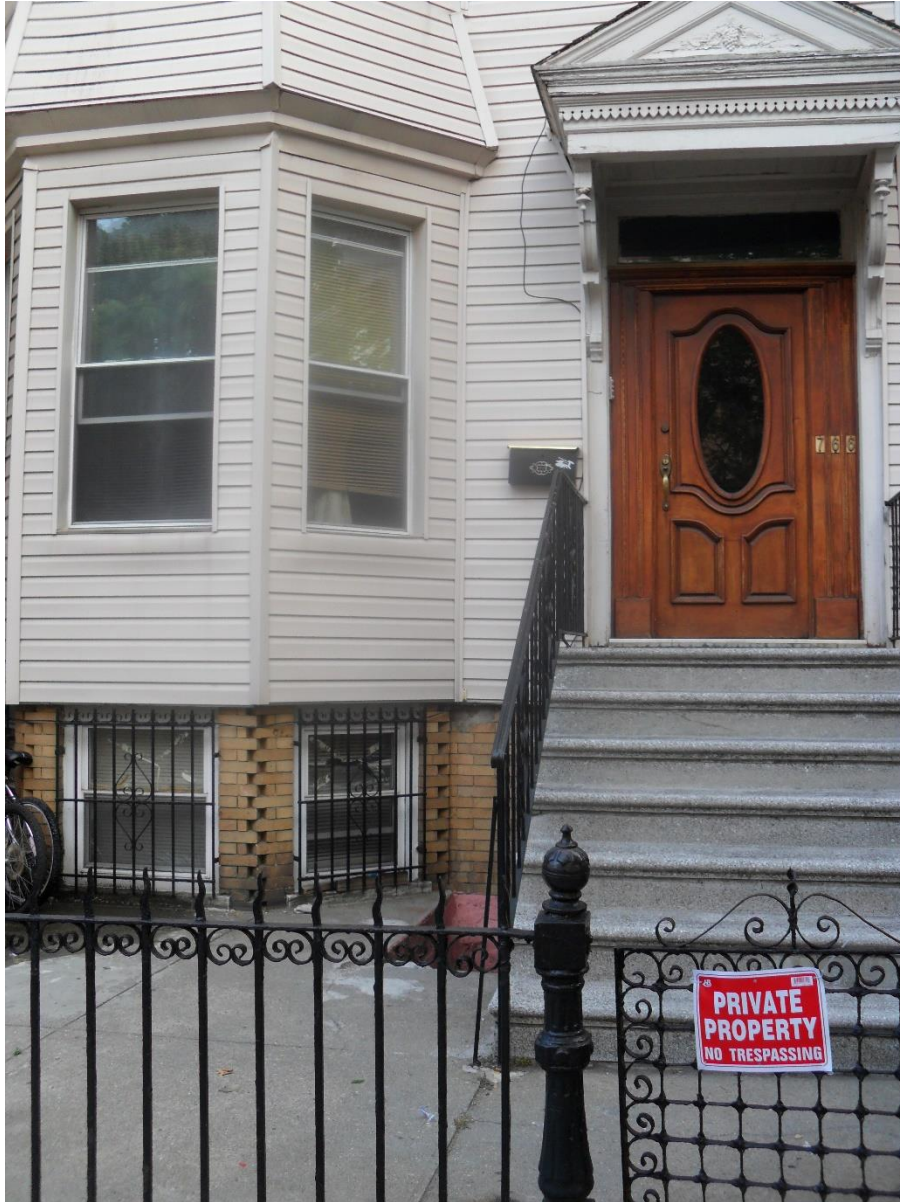
Anexo B. Sótano. Ilustración Propia. 11/07/2013. Ubicada muy cerca del parque central, es la casa que renta la familia Robles, el sótano tiene esas dos ventanas a la altura de la escalera, habitado por un matrimonio con dos hijos y los dos hermanos trabajadores de las bodegas fresqueras. El piso principal, donde vive Carmen Robles con su pareja y dos hijas adolescentes, el segundo piso lo habita un matrimonio dominicano cercano al marido de Carmen.
