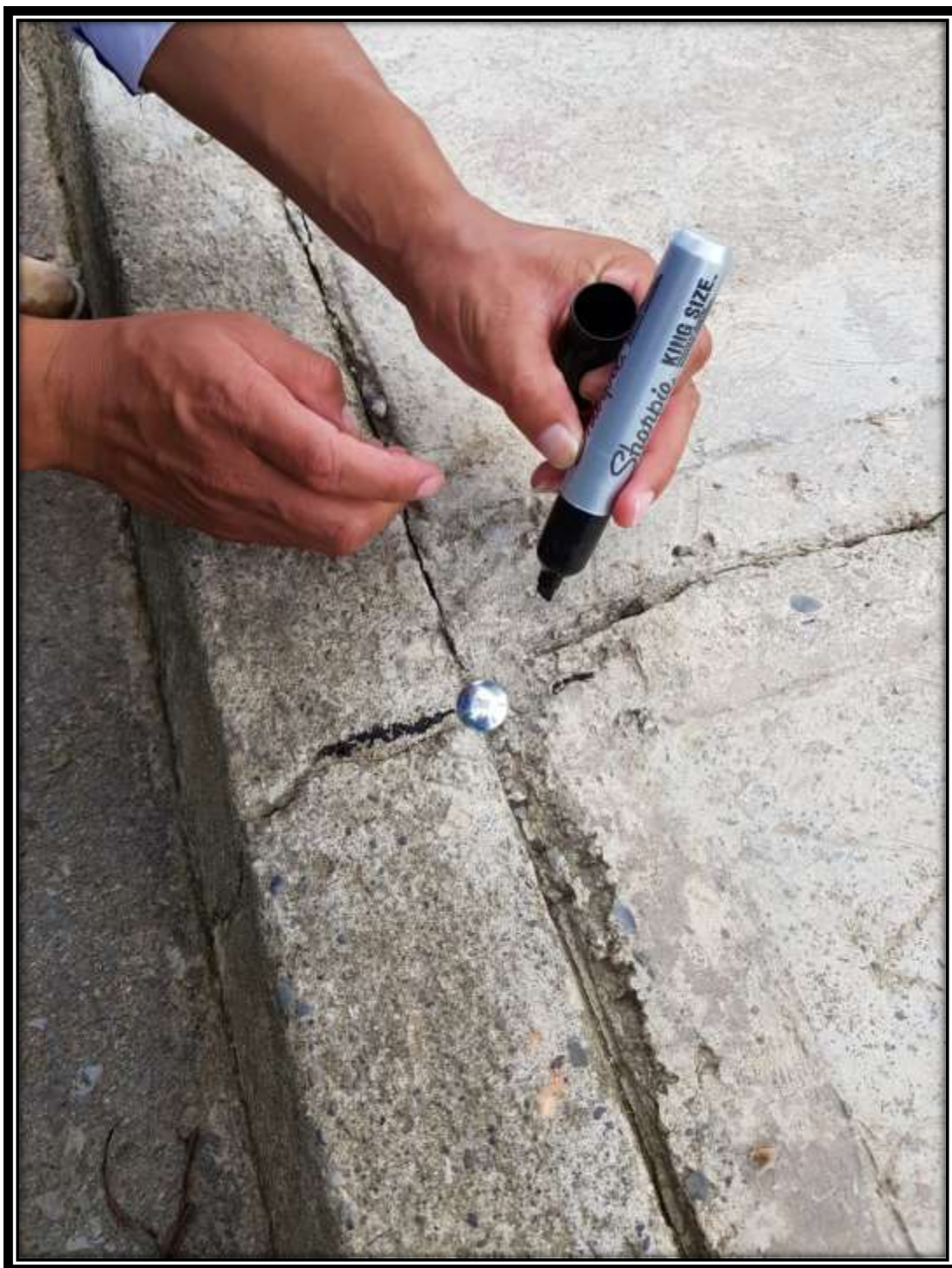
Imagen 22. Marcaje de B.N con plumón para tener una mejor relación de todos. (Fuente: foto del autor)
