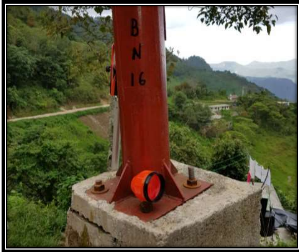
Imagen 18. Observación y colocación de B.N en base de lámpara para establecerlo mejor. (Fuente: foto del autor)
