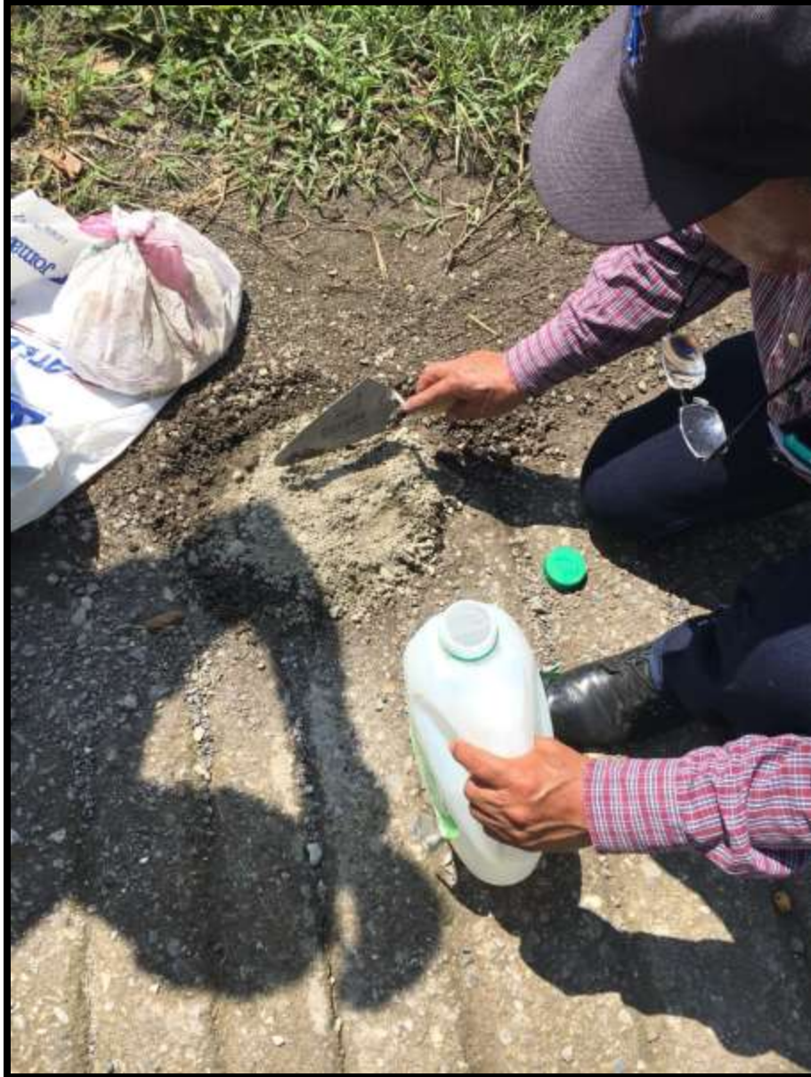
Imagen 15. Uso de concreto para garantizar la conservación de los puntos de control. (Fuente: foto del autor)
