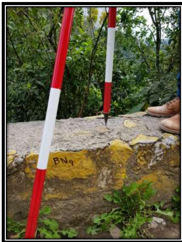
Imagen 17. Colocación de B.N con clavo de concreto y marcaje con nomenclatura. (Fuente: foto del autor)
