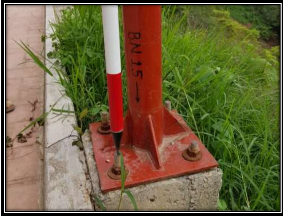
Imagen 19. Colocación de B.N en base de concreto y tornillo de lámpara. (Fuente: foto del autor)
