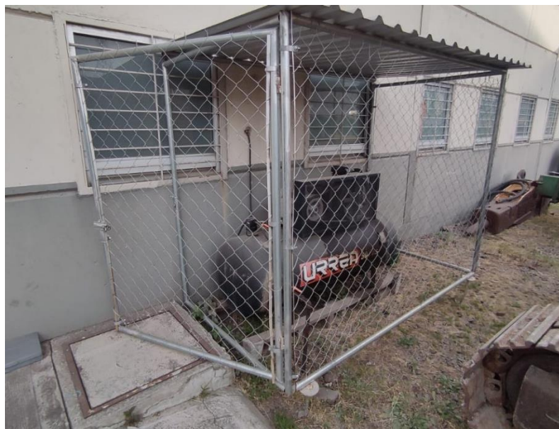
Ilustración 33. Malla protectora para el compresor de aire
