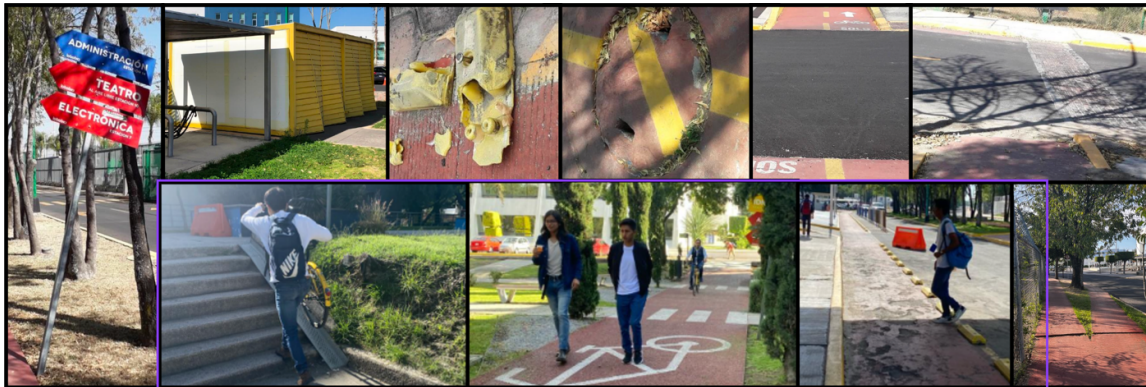
Figura 14: Problemas en la infraestructura ciclista de CU
