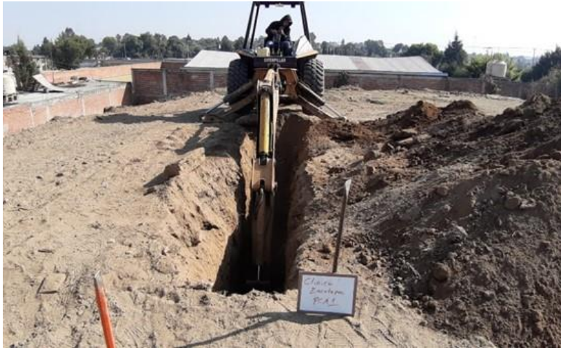
Figura 3.1 excavación de pozo a cielo abierto
