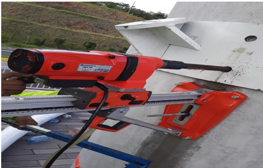
*Ilustraciones 34a – 34b. Barrenación y colocación de correa maestra*
