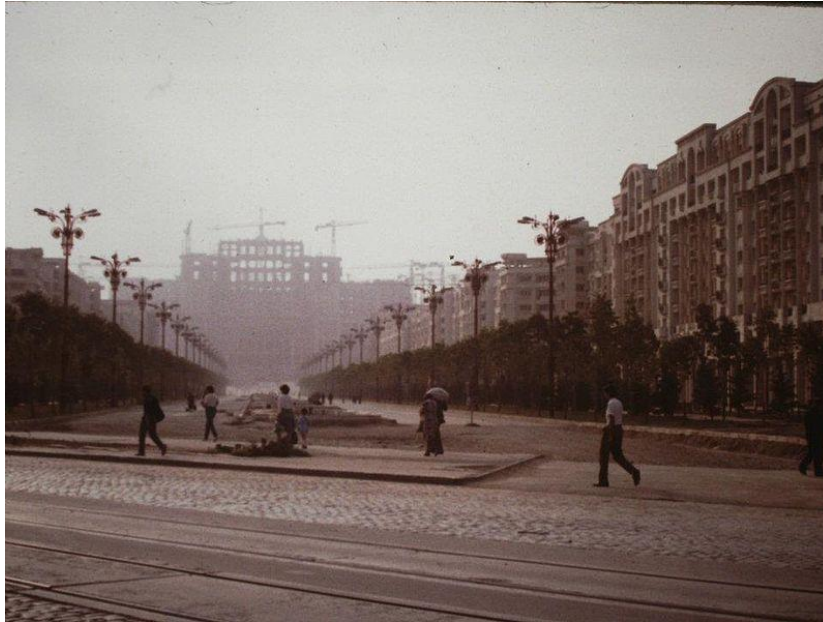
Figura 15. Construcción del Palacio del Parlamento en Rumania en 1986 (Edelman, 1989)
