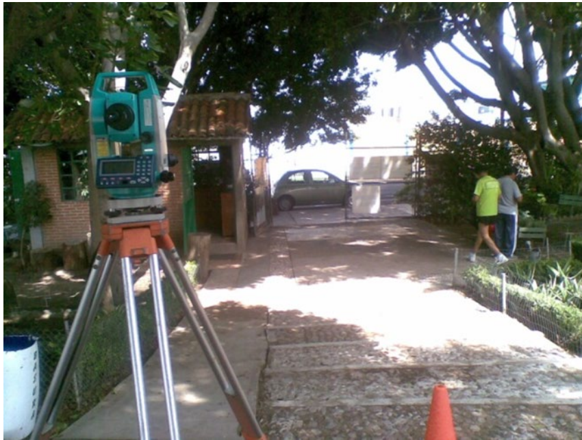
Figura 18. Establecimiento de estación en taquilla
