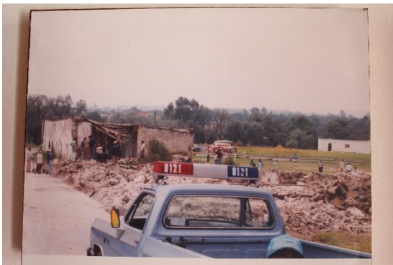
Imagen 50. Demolición viviendas obreras FHyTA (2020)
