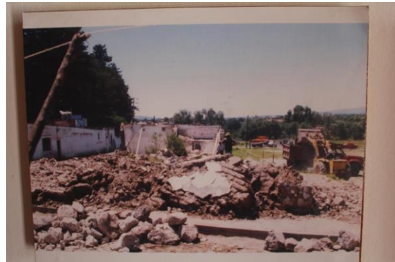
Imagen 49. Demolición viviendas obreras FHyTA (2020)
