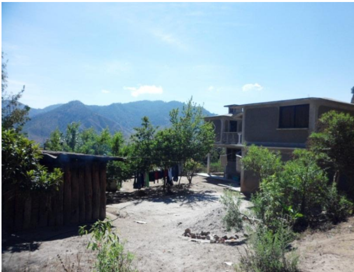
Figura 19: Contrastes. Esta es una construcción común entre las familias con migración externa (Estados Unidos). Los detalles y acabados contrastan con la persistencia de cocinas de humo de materiales como: madera y lámina.
