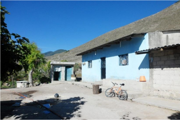
Figura 31: Hogar con techo de lámina. Entre los materiales comunmente utilizados para la contrucción están: láminas de asbesto, metal o cartón.
