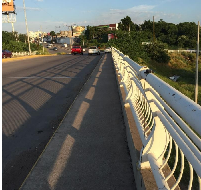
Figura 11. Antena ANN-MB-00 de U-blox colocada sobre el parapeto en el primer claro del puente Isla Musalá.
