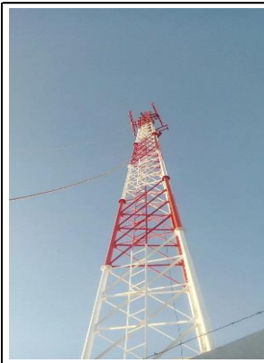
FOTOGRAFIA DE ESTRUCTURA
