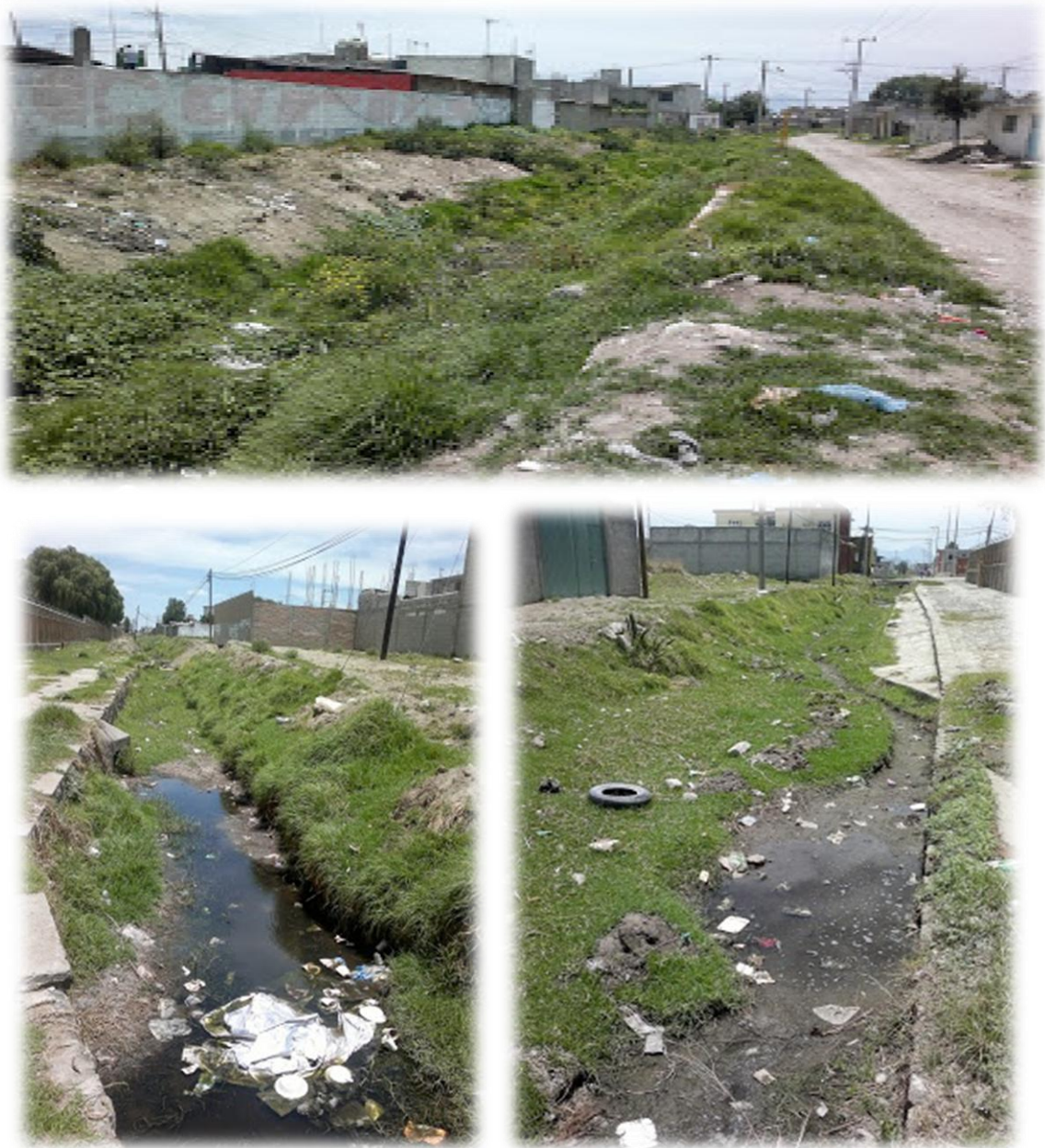
Figura 11.10 Drenaje a cielo abierto en el área de estudio. Fuente: Barrera T. M.
