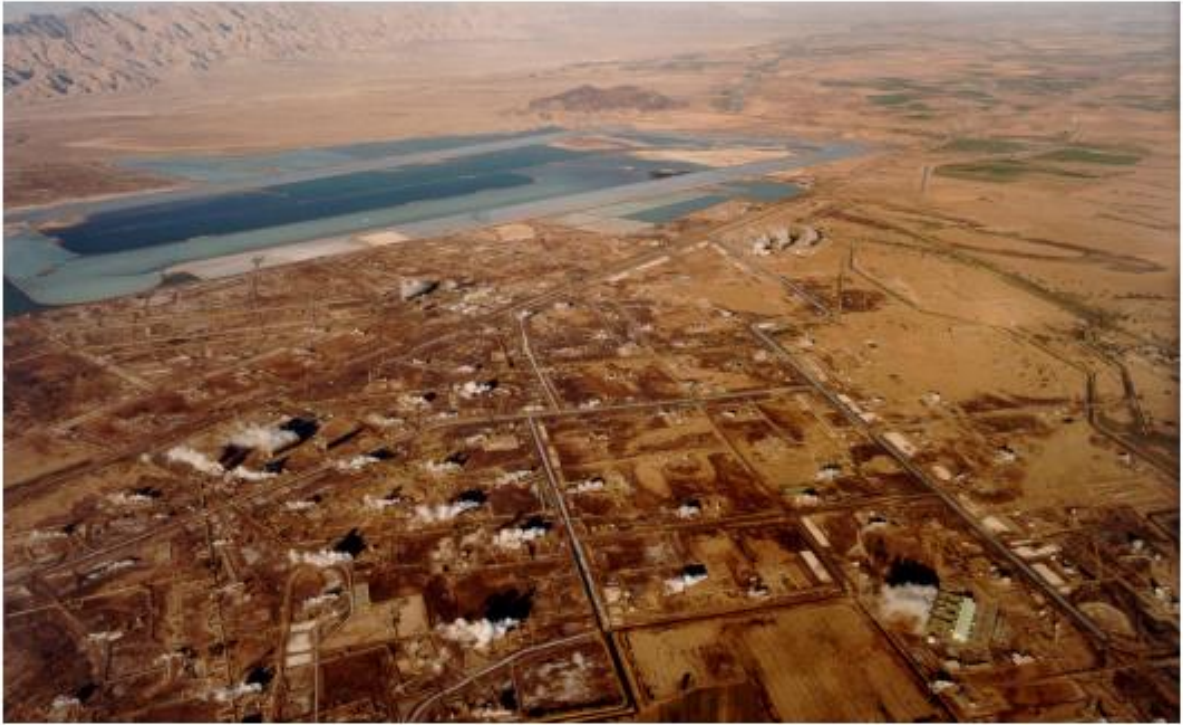
Fig. 3. Laguna de evaporación en el Campo Geotérmico de Cerro Prieto (CFE, 2011)
