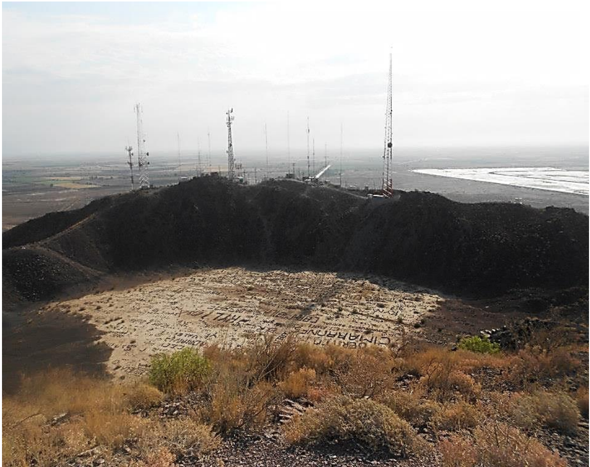
Fig. 7 Infraestructura del Campo Geotérmico de Cerro Prieto. Fuente: Propia
