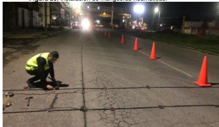
Figura 20. Instalación de mangueras neumáticas.
