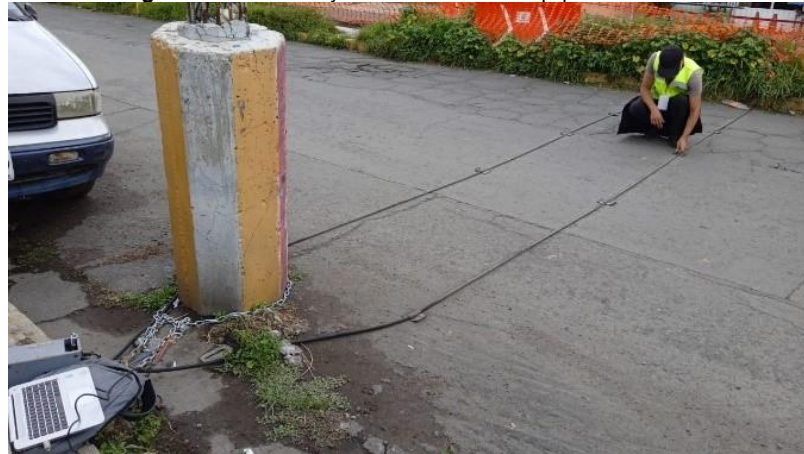
Figura 21. Monitoreo y mantenimiento de equipos.
