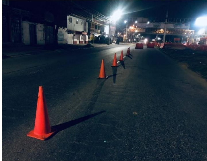
Figura 19. Señalamiento para desvío de vehículos.
