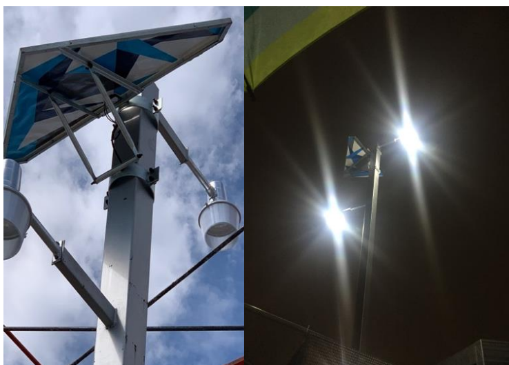
Figura 3.21. (a) La instalación del panel fotovoltaico; (b) El sistema fotovoltaico autónomo en funcionamiento
