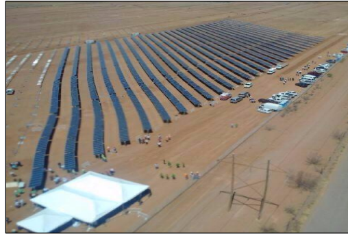
Figura 1.6 PLANTA FOTOVOLTAICA LOS SANTOS SOLAR 1 [10]
