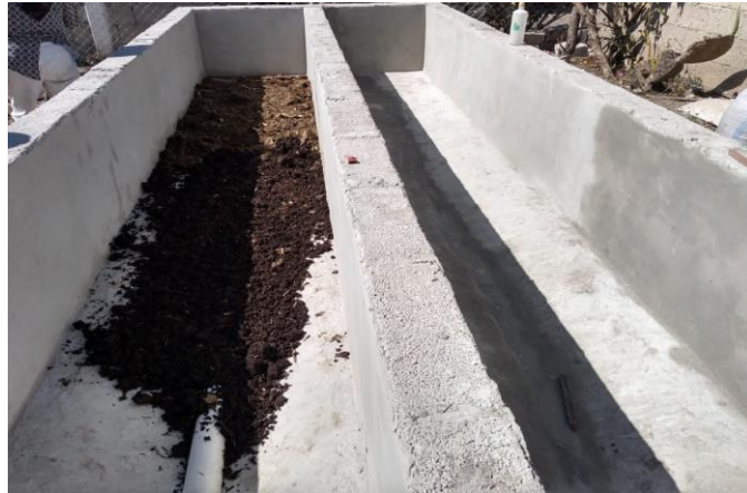
Figura 5. Colocación en los tanques previamente preparado.
