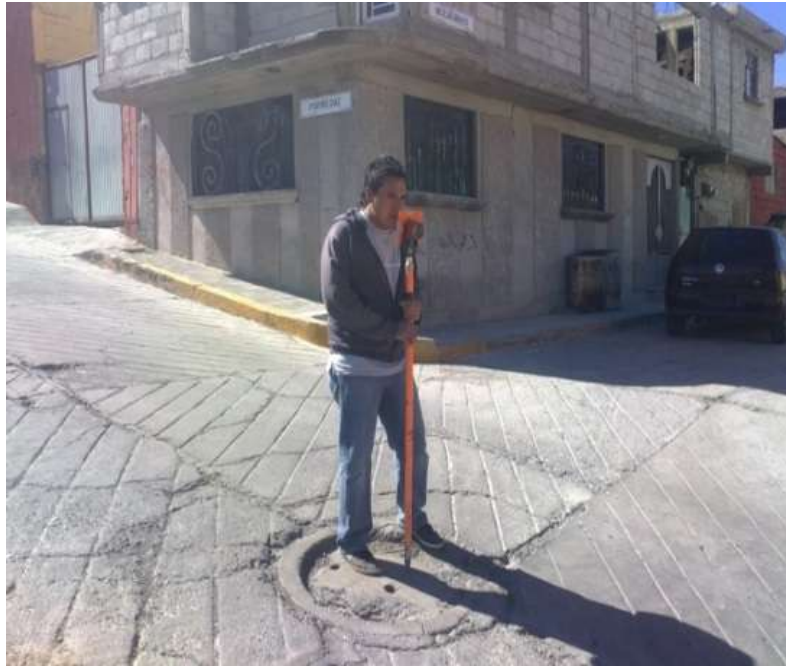
Figura 3.1. Momento en que uno de los estudiantes en el proceso de toma de datos relacionado con el levantamiento topográfico.
