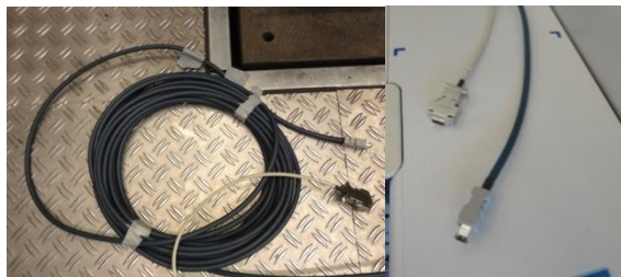
Figura 5. Cables de conexión dentro del dinamómetro
