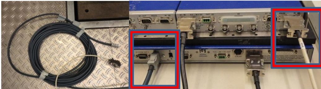
Figura 14. Cables de conexión y entradas a los amplificadores
