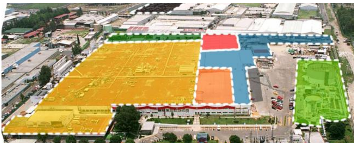
Figura 10 VISTA DE LA PLANTA
